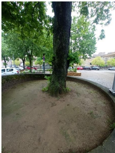
Photo n°7 : tassement du sol (arbre n°3)
