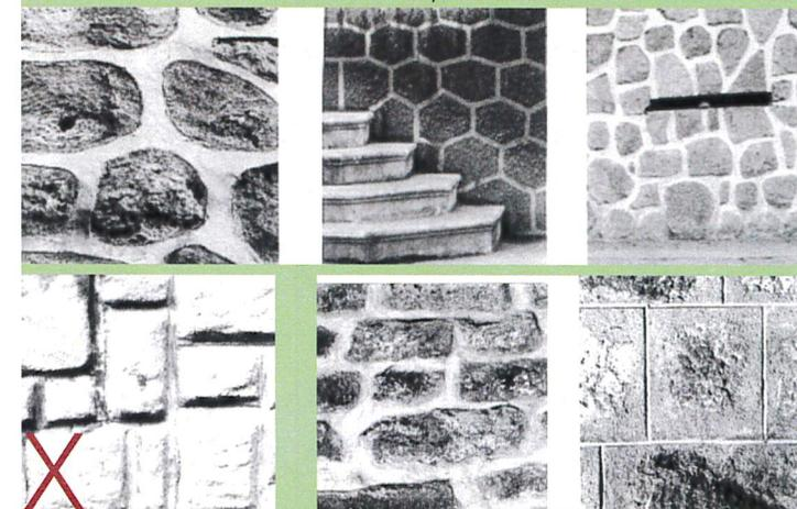
*Lors d'une restauration ou d'un ravalement, la réfection des joints est nécessaire. Il convient d'éliminer les joints trop durs (réalisés avec des ciments artificiels), les joints pulvérulents, ou de purger les joints dégarnis ou en passe de se vider.*
